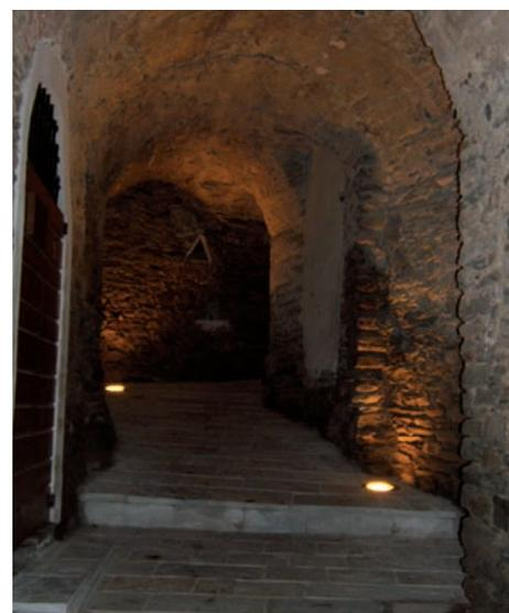
Le passage sous l'église paroissiale de San Martinu a fait l'objet d'une restauration consistant à l'enfouissement de la ligne électrique de moyenne tension, la réalisation d'un dallage en pierres locales et l'installation d'un éclairage au sol. Cette opération a permis de mettre en valeur ce site, particulièrement fréquenté par les villageois et les touristes.
